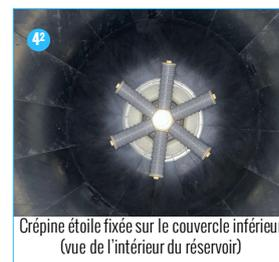
Crépine étoile fixée sur le couvercle inférieur (vue de l'intérieur du réservoir)
